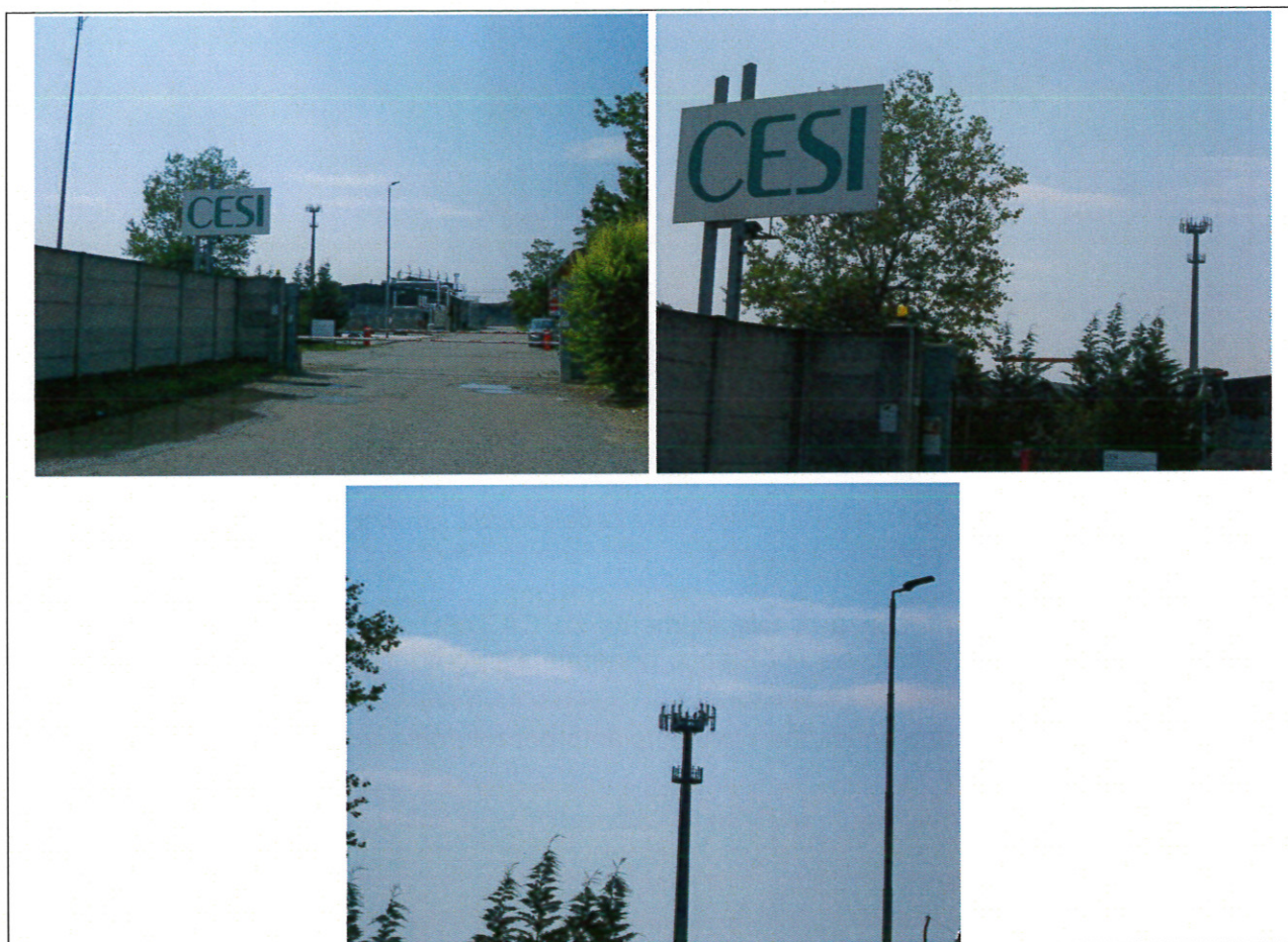
Figura 3.12: Documentazione fotografica della stazione radiobase Wind Via Rubattino 84
