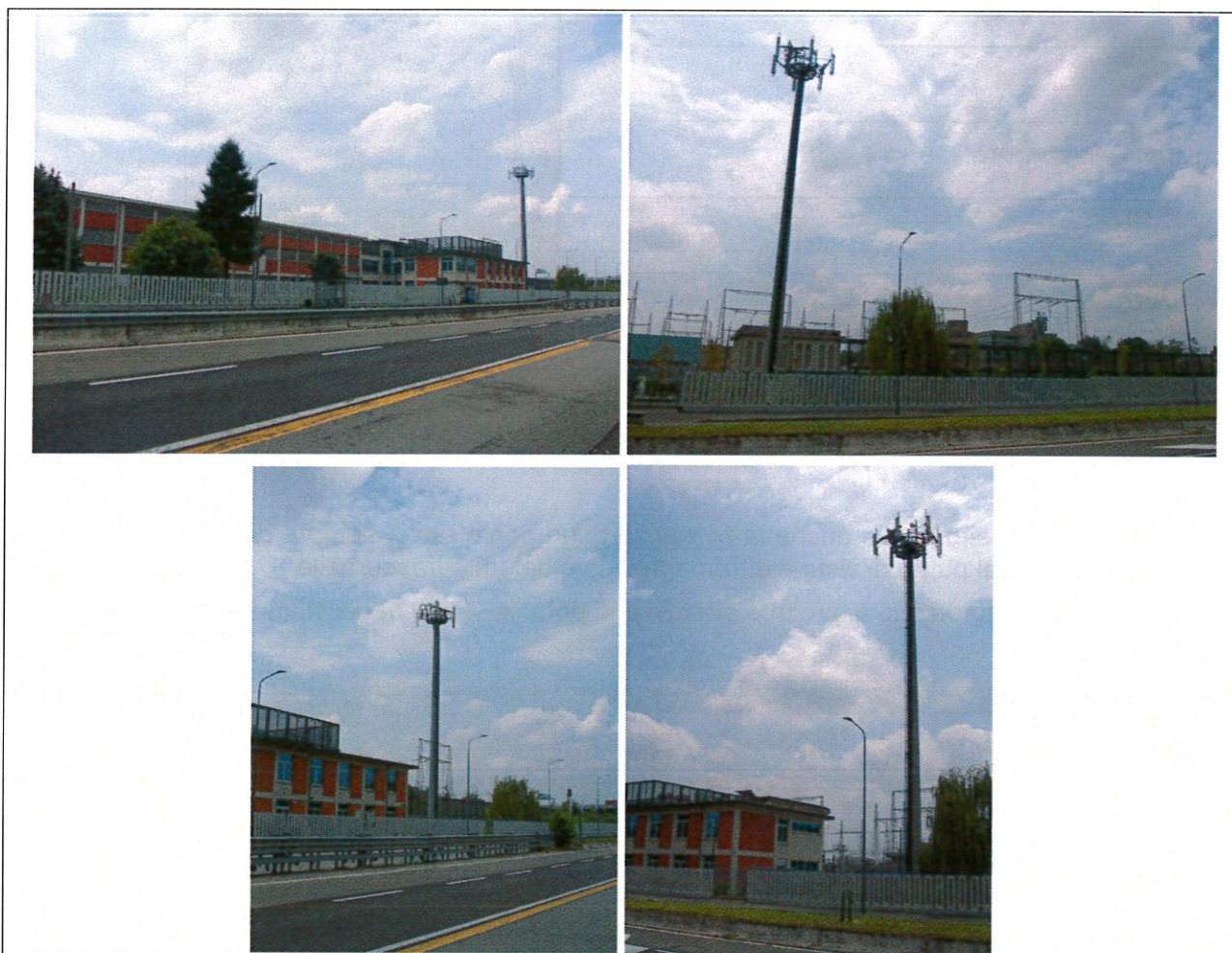
Figura 3.8: Documentazione fotografica della stazione radiobase Wind Via Rubattino 84
