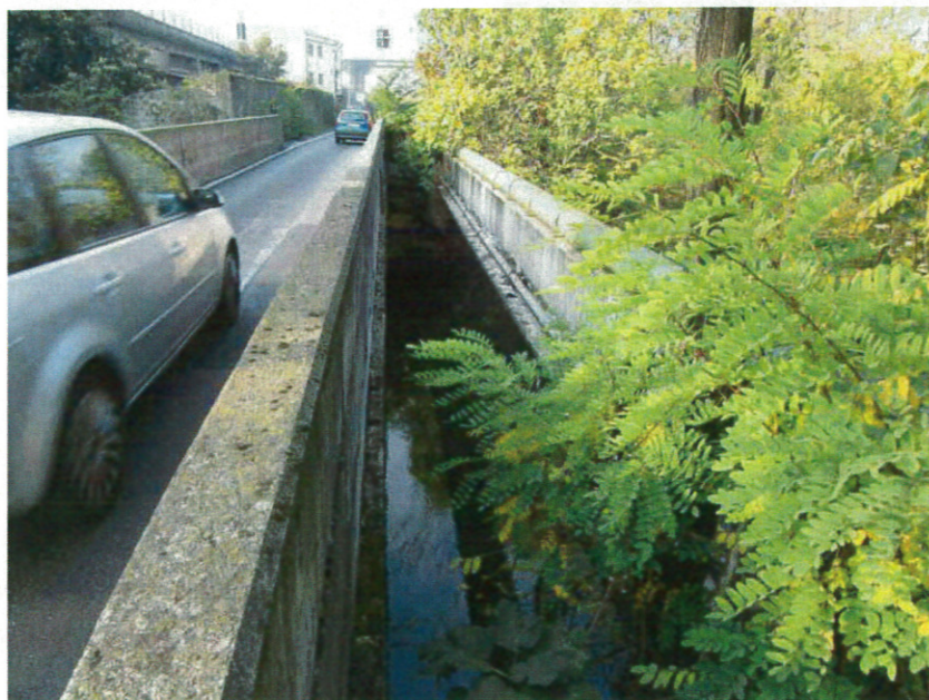
Vista dalla sponda idrografica sinistra della trave in cemento a supporto della tubazione presente a monte dell'attraversamento di Viale Lazio/Via Cima.
