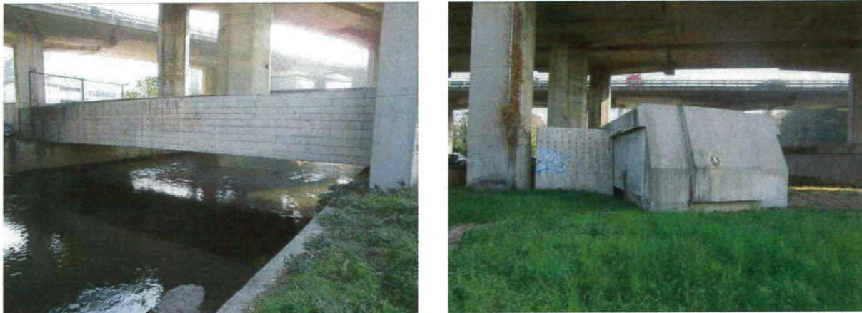
Vista da monte della sezione di ingresso della seconda trave in cemento armato (sinistra) e spessore della stessa dove si possono notare le due strutture accoppiate (destra).
