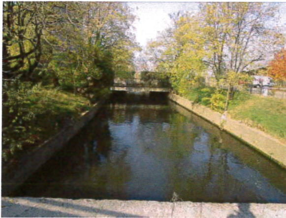
Vista di uno dei tratti caratterizzati da sponde in cemento armato (sinistra) e di quello con sponde caratterizzate da scarpate naturali (destra).
