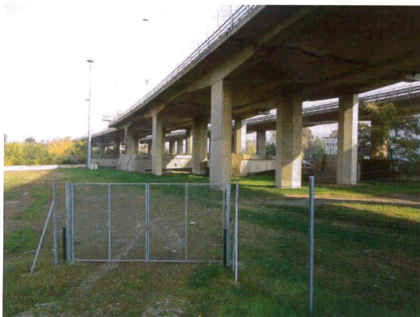
Vista dell'attraversamento della Tangenziale Est e delle travi in cemento armato a supporto dei piloni.
