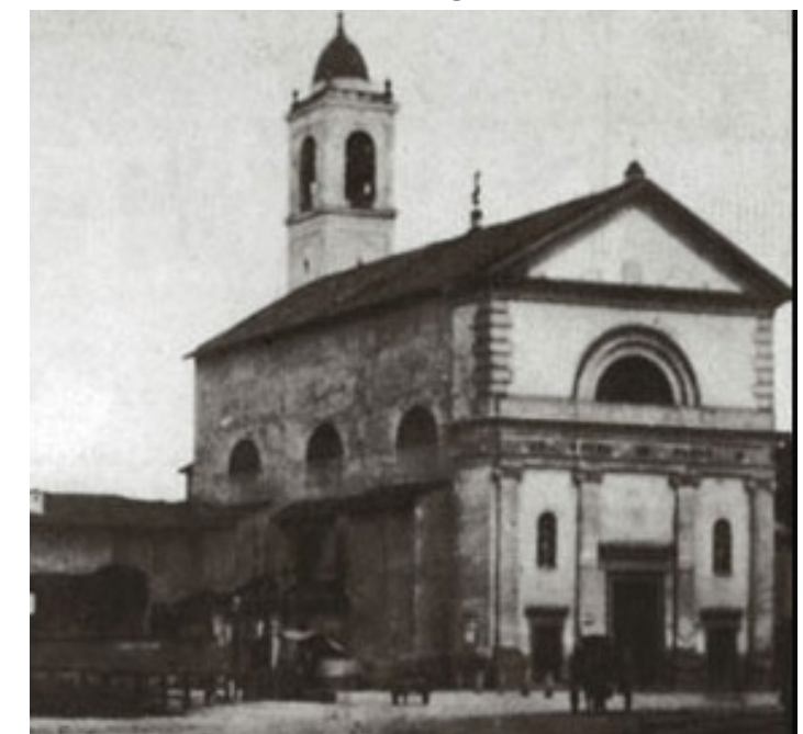
Fig. 9: La chiesa di S. Pietro in Sala prima della demolizione nel XX secolo.
